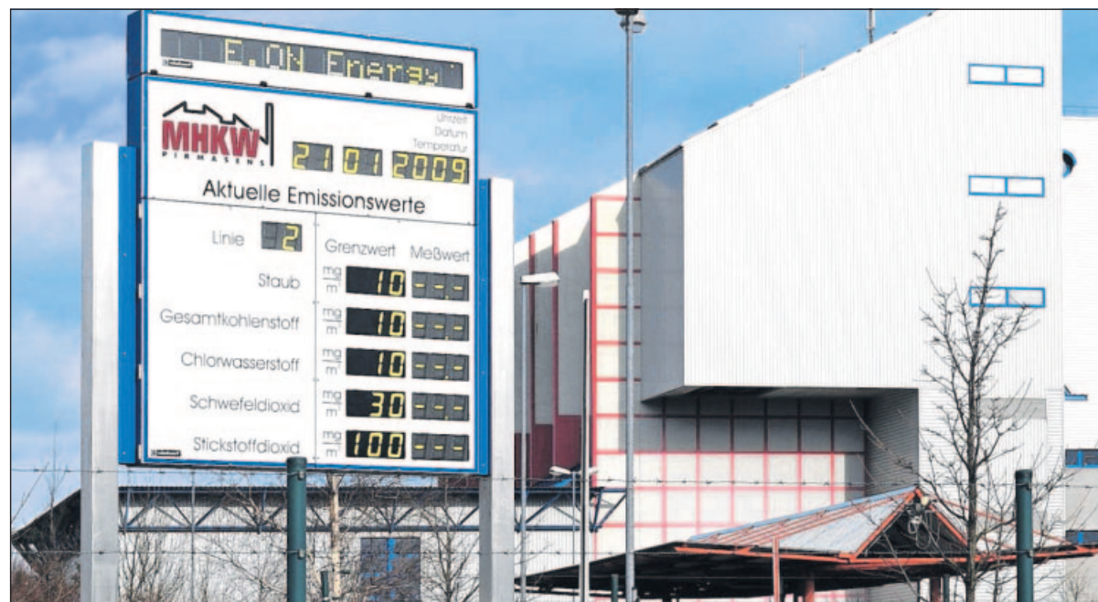
Liegt direkt an der B 10 und im Stadtteil Fehrbach: das Müllheizkraftwerk Pirmasens.
